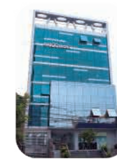
Edif. Efi100tech 2 San Isidro
