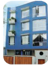
Edif. Atahualpa Miraflores
