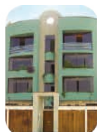
Edif. Trevor San Borja
