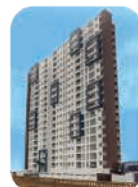
Edif. Barranco V.C. Barranco
