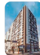
Edif. Ser-k 2da Etapa Barranco
