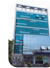
Edif. Efi100tech 2 San Isidro
